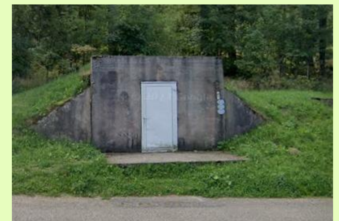
La cuve de pompage:
