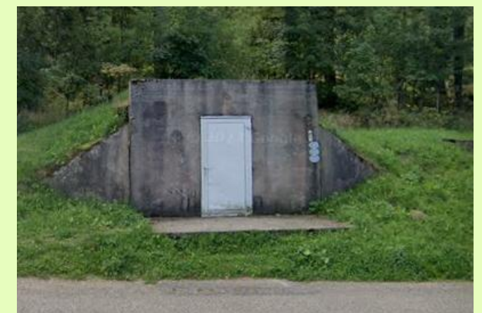
La cuve de pompage:
